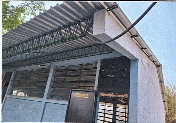
Foto 3: Techo de Segundo Grado
