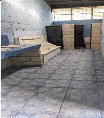
Foto 1: Mejoramiento de Módulo de Sanitario de Niños
