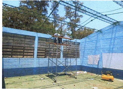
Foto 2: Reforzamiento de Estructura de techo
