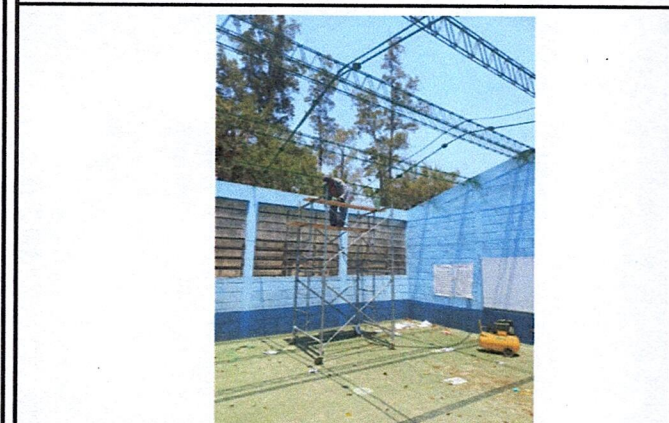
Foto 3: Mejoramiento de estructura de techo
