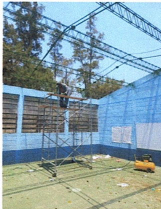
Foto 3: Mejoramiento de estructura de techo
