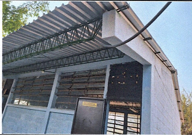
Foto 3: Techo de Segundo Grado
