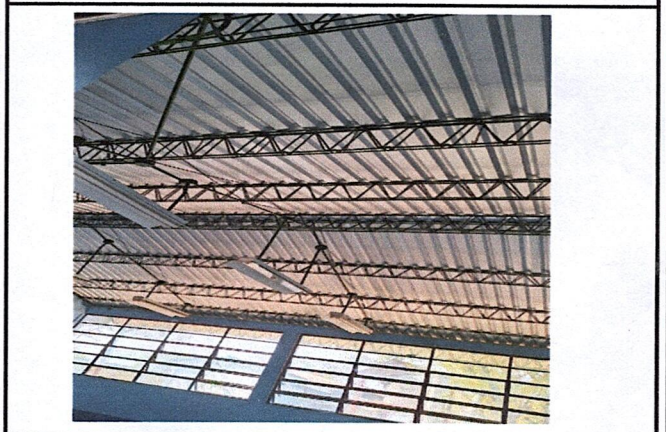
Foto 4: Interior de Aula Recurso Terminado
