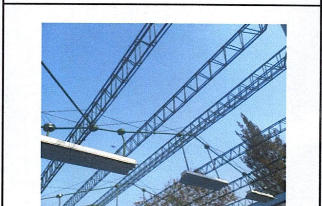
Foto 4: Mejoramiento de la estructura del techo
