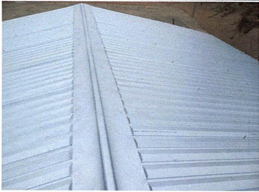
Foto 1: Capotes y láminas colocadas
