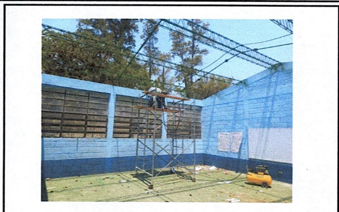
Foto 2: Reforzamiento de Estructura de techo
