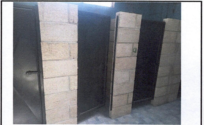
Foto 2: Mejoramiento de Puertas y de las divisiones de sanitario del módulo de niñas
