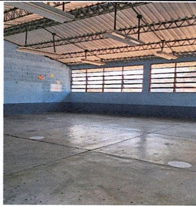
Foto 2: Pernos y remaches colocados segundo grado
