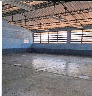
Foto 2: Pernos y remaches colocados segundo grado
