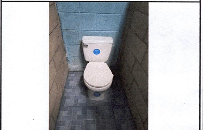
Foto 4: Cambio de Sanitarios, lavamanos y colocación de tabique.
