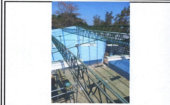
Foto 1: Estructura de Techo Limpia
