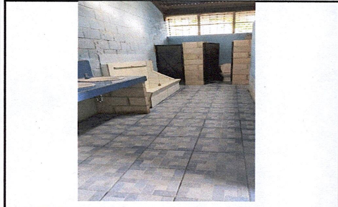
Foto 1: Mejoramiento de Módulo de Sanitario de Niños
