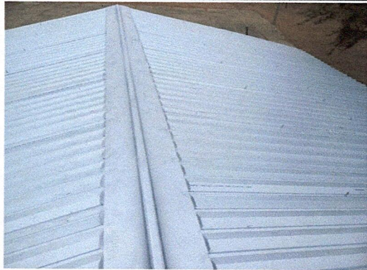
Foto 1: Capotes y láminas colocadas
