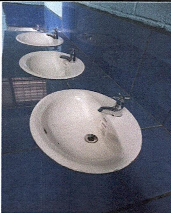
Foto 3: Cambio de Lavamanos en el módulo de niñas y niños
