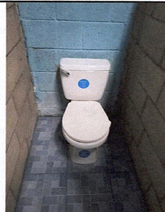
Foto 4: Cambio de Sanitarios, lavamanos y colocación de tabique.
