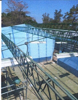
Foto 1: Estructura de Techo Limpia
